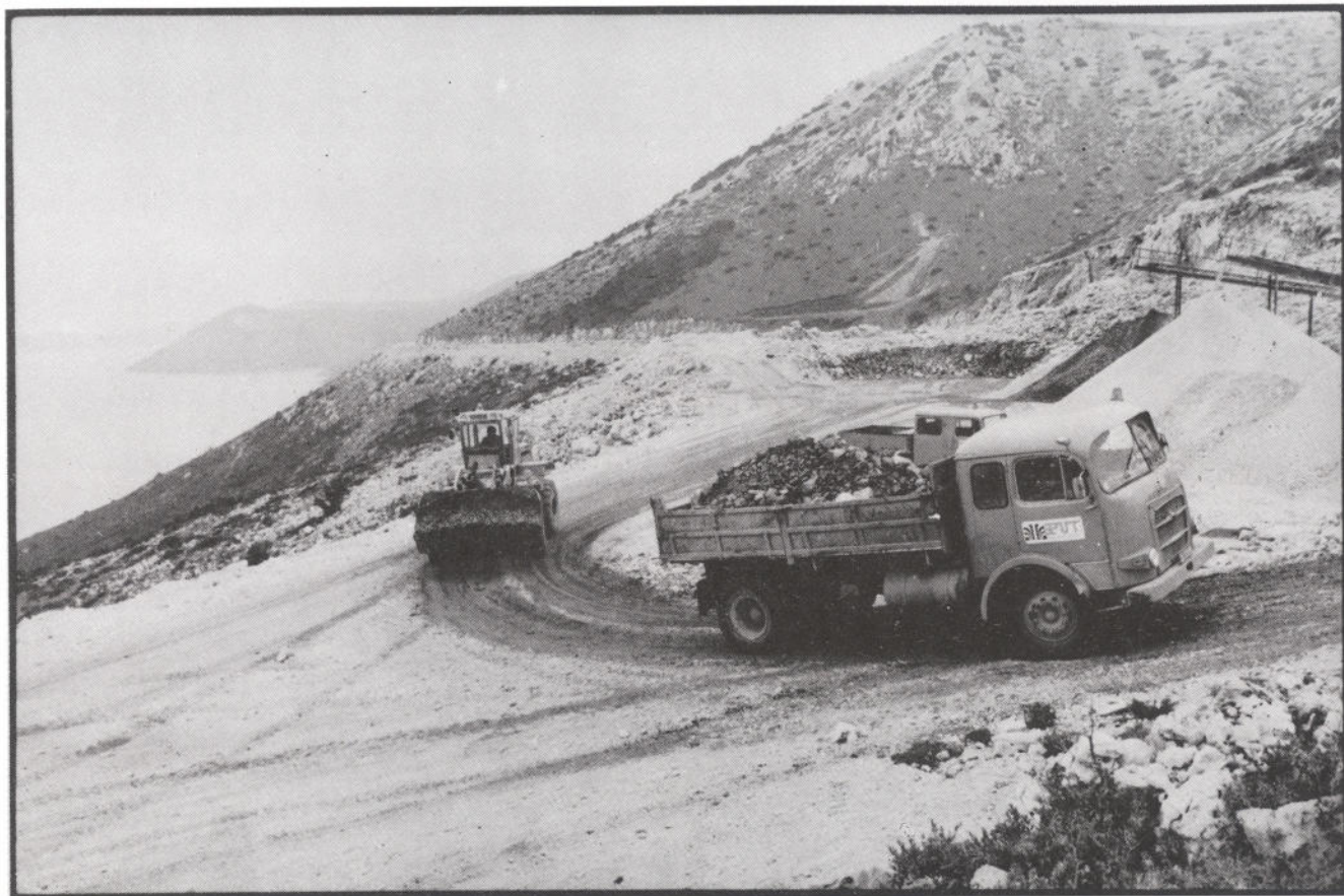
Izgradnja ceste na Dugom otoku
